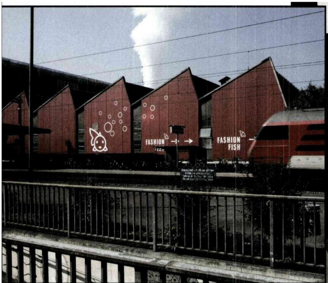
Der grösste Factory Outlet der Schweiz: Der «Fashion Fish» in den ehemaligen Schuh-Produktionshallen von Bally in Schönenerd.
